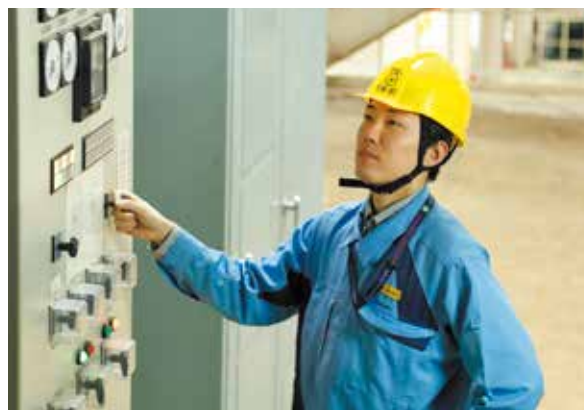
中央制御室だけではなく、じかに現場へ赴いて機器の異音の有無をチェックすることやバルブ操作、非常用電源の確認なども佐藤さんの仕事です。
