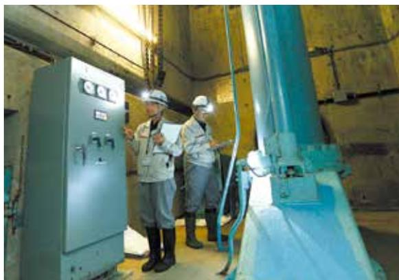
有事の際に放流を行うための、放流管操作室の点検。周りのコンクリートの壁も60年以上前のものです。
