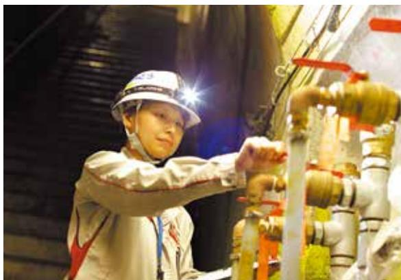
ダムを構築するコンクリートの分厚い壁でも、水は少しずつにじんで内部に入ってきます。その排水量を確認し、ダムに異常がないかをチェック。
